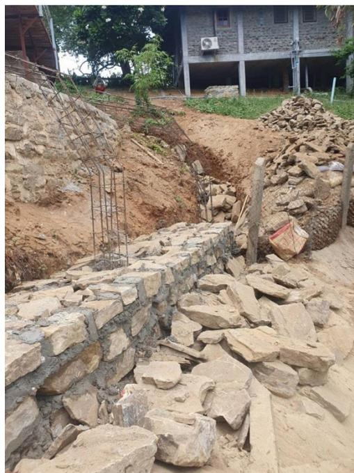
Comme du côté de la Lumière d'Amour, les ouvriers ont dû creuser très bas pour atteindre une roche solide et inébranlable. Des barres d'armature ont ensuite été posées et le mur de soutènement a été reconstruit à l'aide de grosses pierres et de quantités de ciment.
