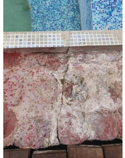
Après le passage du cyclone Mocha, Lyon a inspecté l'ensemble de l'enceinte de Lei Thar Gone et a constaté que l'énorme mur de soutènement qui soutenait la zone de la piscine avait été endommagé et devait être reconstruit.
