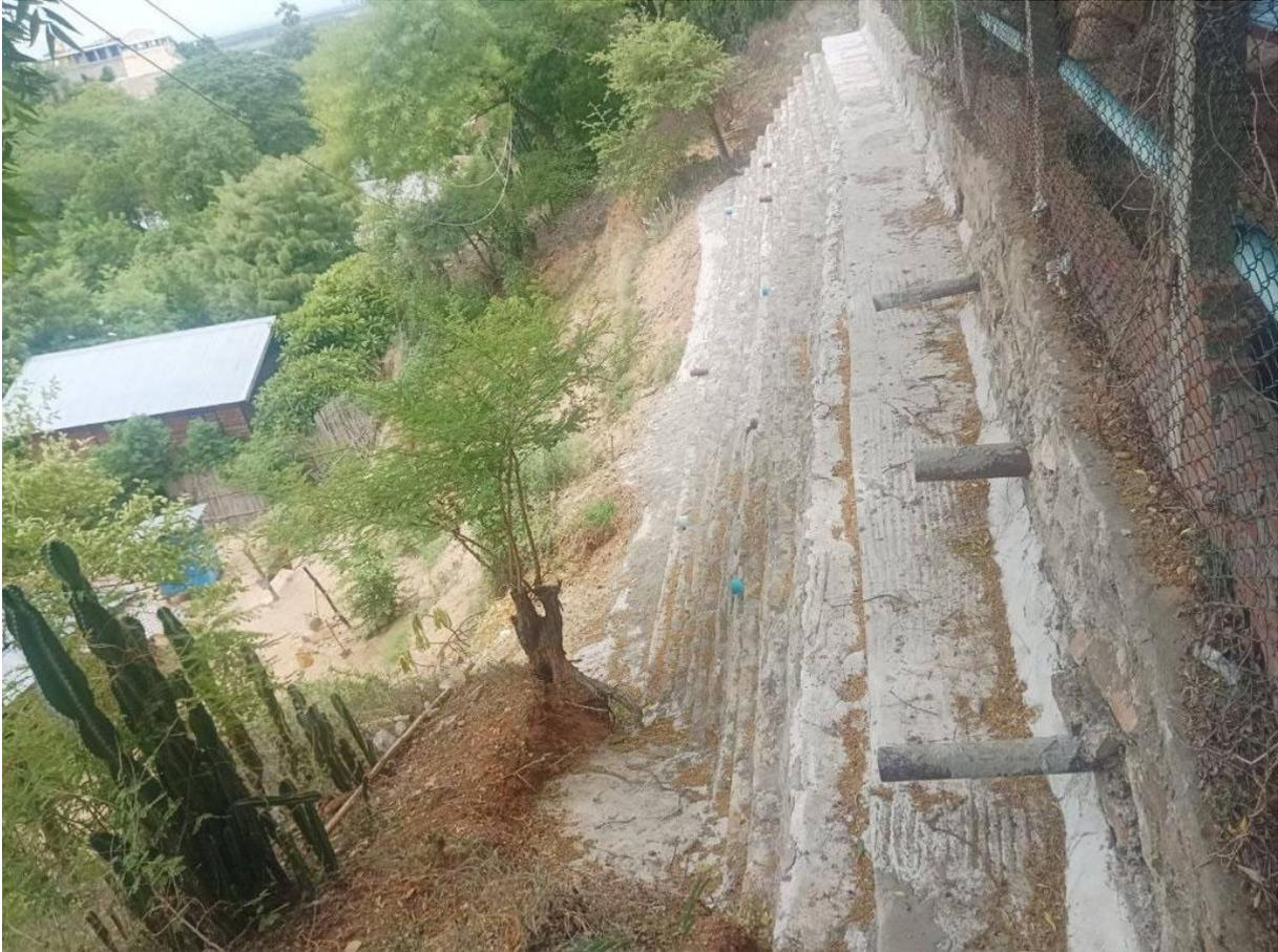
Le mur de soutènement a été entièrement reconstruit. En raison de l'instabilité du sol, les ouvriers ont d'abord dû creuser jusqu'à 1,52 m de profondeur, jusqu'à ce qu'ils atteignent une roche solide et une fondation solide. Ils ont posé des barres d'armature et utilisé des quantités de ciment pour stabiliser la construction.
